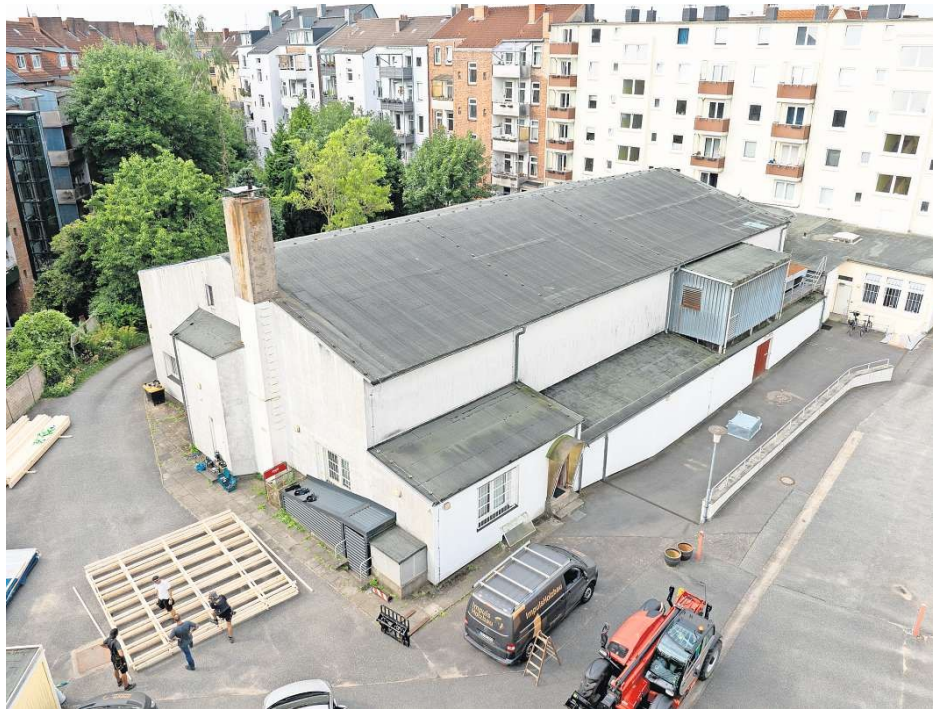
Die Dachkonstruktion der Hinterhof-Halle (Bildmitte), in der die drei Kinosäle des Metro-Kinos liegen, ist akut einsturzgefährdet und muss saniert werden. Fachleute bereiten mit Kranwagen und Holzpaletten die Begehung und Öffnung des Dachstuhls von außen vor.
