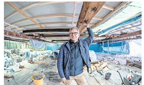
Das Dach des Metro-Kinos ist diese Woche entfernt worden. Im nächsten Schritt soll unter einem provisorischen Dach das Dachgebälk erneuert werden, erklärt Geschäftsführer Jan Sellmer. FOTO: THOMAS EISENKRAETZER
