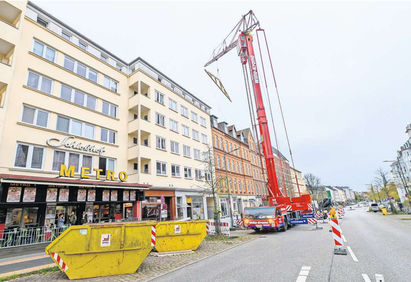
Die riesigen Holzdreiecke von 18 Metern Länge musste ein Spezialkran über die Dächer hinweg heben. FOTOS: SVEN JANSSEN
